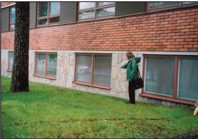
Kuva 1. Vesa osoittaa epäilyttävää ikkunaa.
